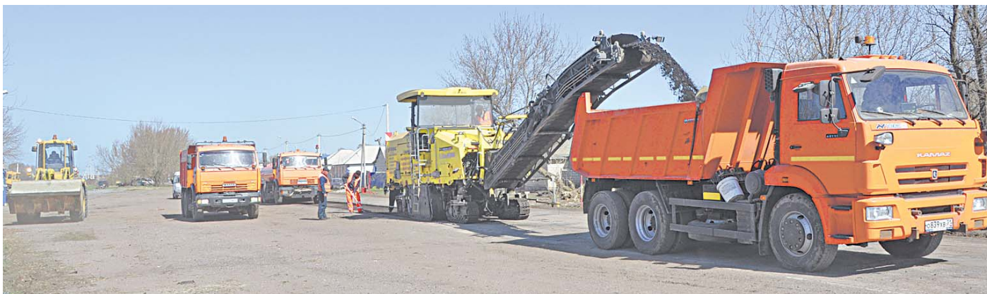
Техника на фрезеровании асфальтного покрытия
