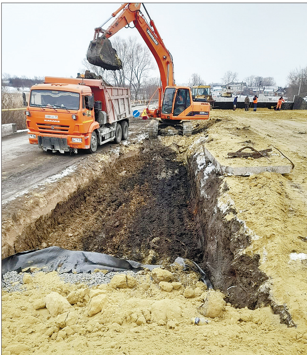
На дорогах района разворачиваются ремонтные и строительные работы
